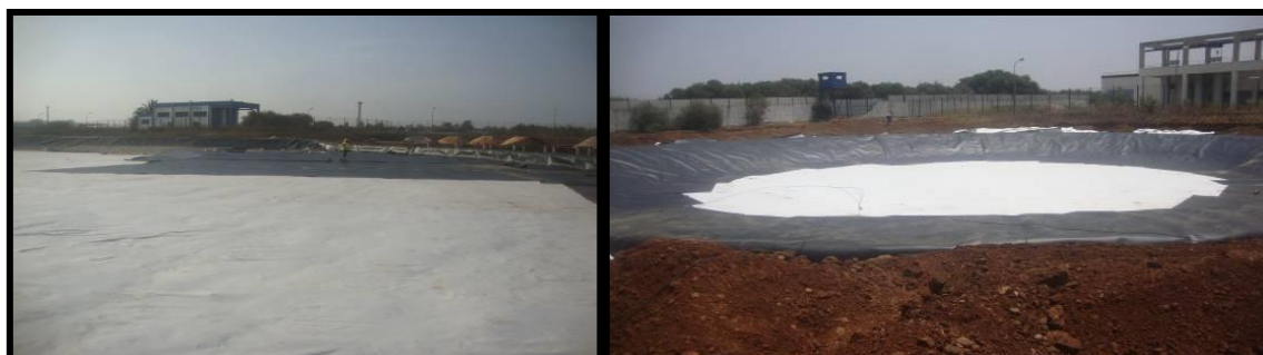
Figure 5. Mise en œuvre du géotextile Figure 6. Mise en œuvre de la géomembrane
