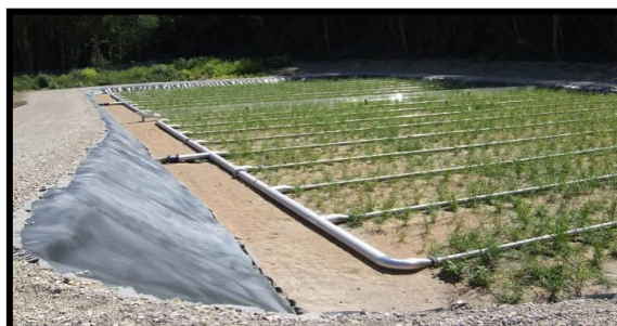
Figure 7. Système de drainage des eaux avec plantation de roseaux
